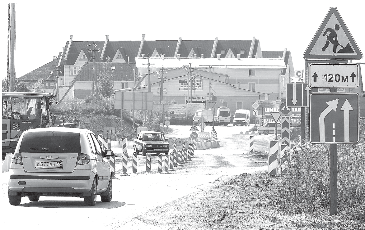
В прошлом году на ремонт и строительство дорог на Вологодчине из федерального бюджета было привлечено 8,3 миллиарда рублей. | Фото из архива газеты «Красный Север»
