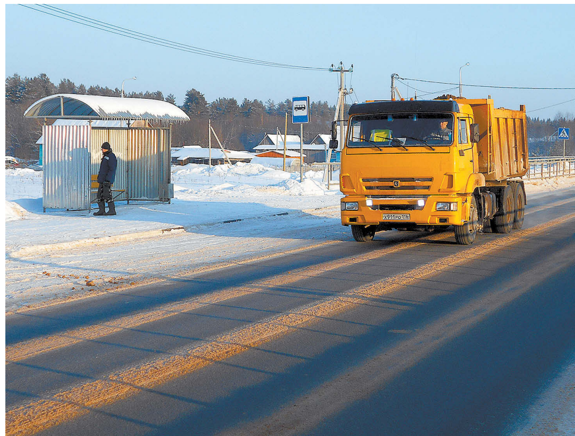
Новая федеральная трасса на Вытегру в районе поселка Депо. Помимо широкой проезжей части здесь появились и пешеходные тротуары, отделенные от дороги металлическими ограждениями.
