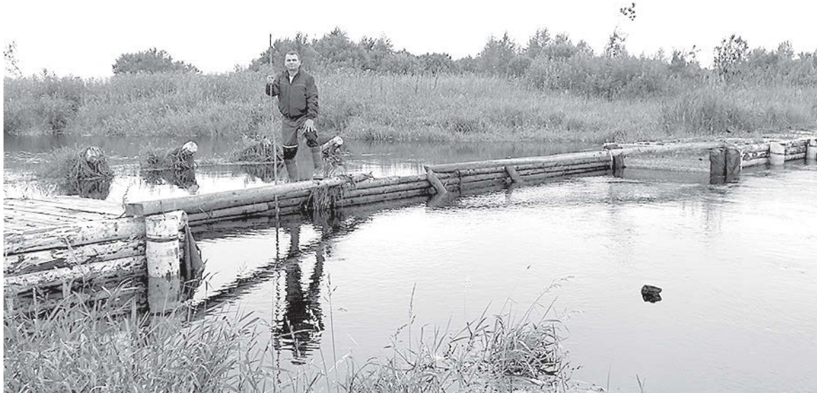
На общем виде плотины хорошо видны следы несанкционированной «достройки» - перегородившие выемку брусья. | Фото автора
