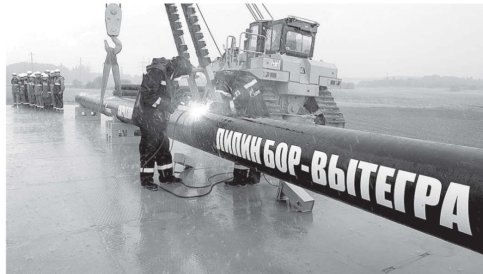
Строительство газопровода-отвода к городам Кириллов - Белозерск - Липин Бор - Вытегра.
