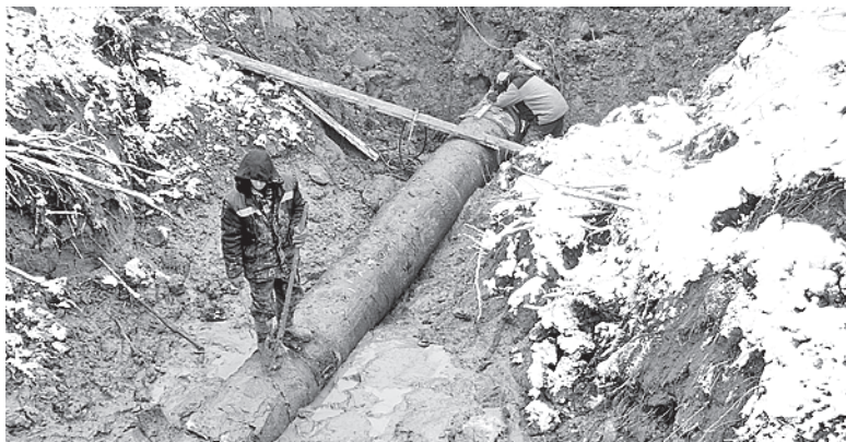
Работы по восстановлению водовода начались сразу же после прорыва.
