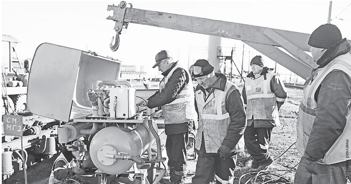
Масштабные работы по модернизации горочного хозяйства ведутся на путях попеременно, сортировочная станция при этом продолжает расформировывать составы. | Фото Лилии Сенченко
