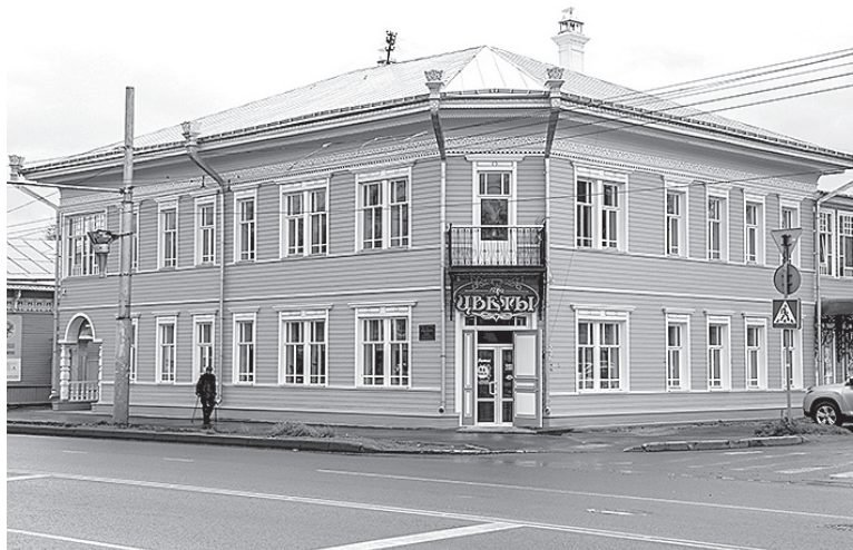
Внутри дома собственник здания планирует провести ремонтно-реставрационные работы. | Фото Сергея Юрова
