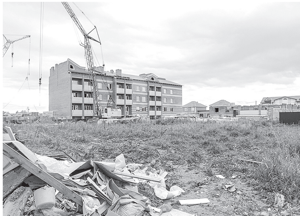
На стройплощадке в деревне Алексин по-прежнему тишина. | Фото Валентины Певцовой
