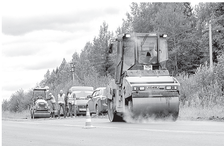
Ремонт дороги Чекшино - Тотма - Никольск продолжится и в следующем году.
