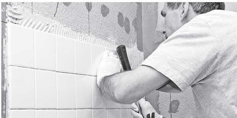
Заделка швов герметиком защитит плитку от попадания влаги.
