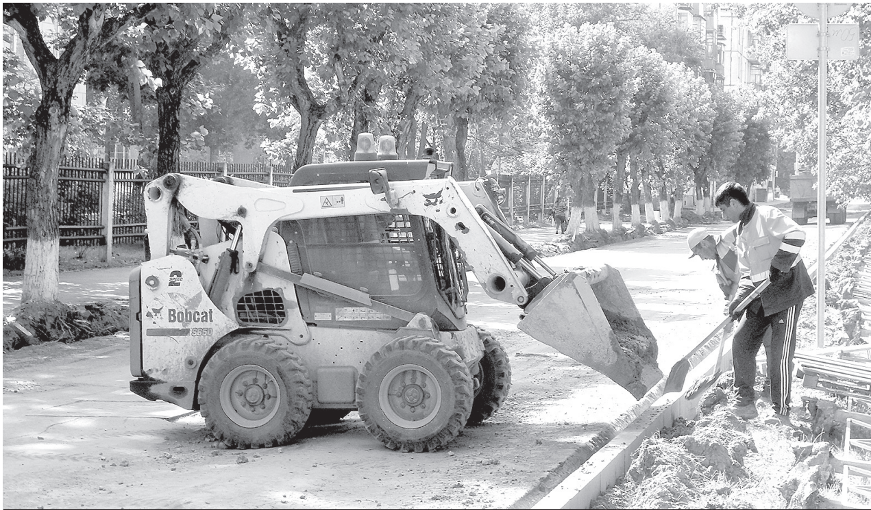
На улице Металлургов ведутся работы по замене дорожного полотна и бордюрного камня. | Фото автора
