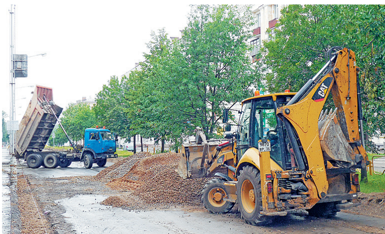
Ремонт улицы Металлургов идет полосами. Это позволяет не перекрывать движение на оживленной магистрали. | Фото автора
