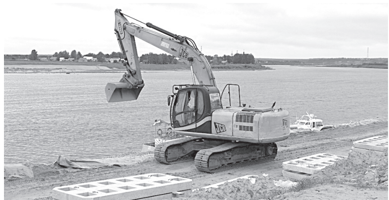
Сейчас основные работы ведутся на левом берегу Сухоны - от центра города к зданию бывшего речного вокзала.
