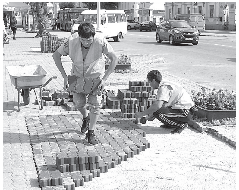
Ремонт тротуарной плитки на Советском проспекте должен завершиться в середине августа. /Фото автора
