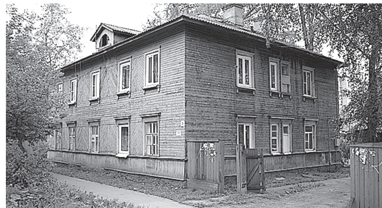
В доме по улице Саммера ремонтируют инженерные сети.
