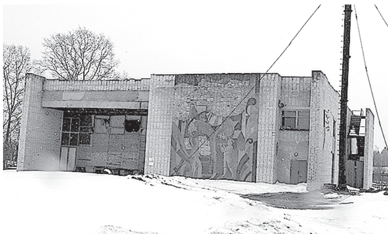
Старое здание ДК в Шонге уже давно нельзя эксплуатировать. /Фото Сергея Юрова
