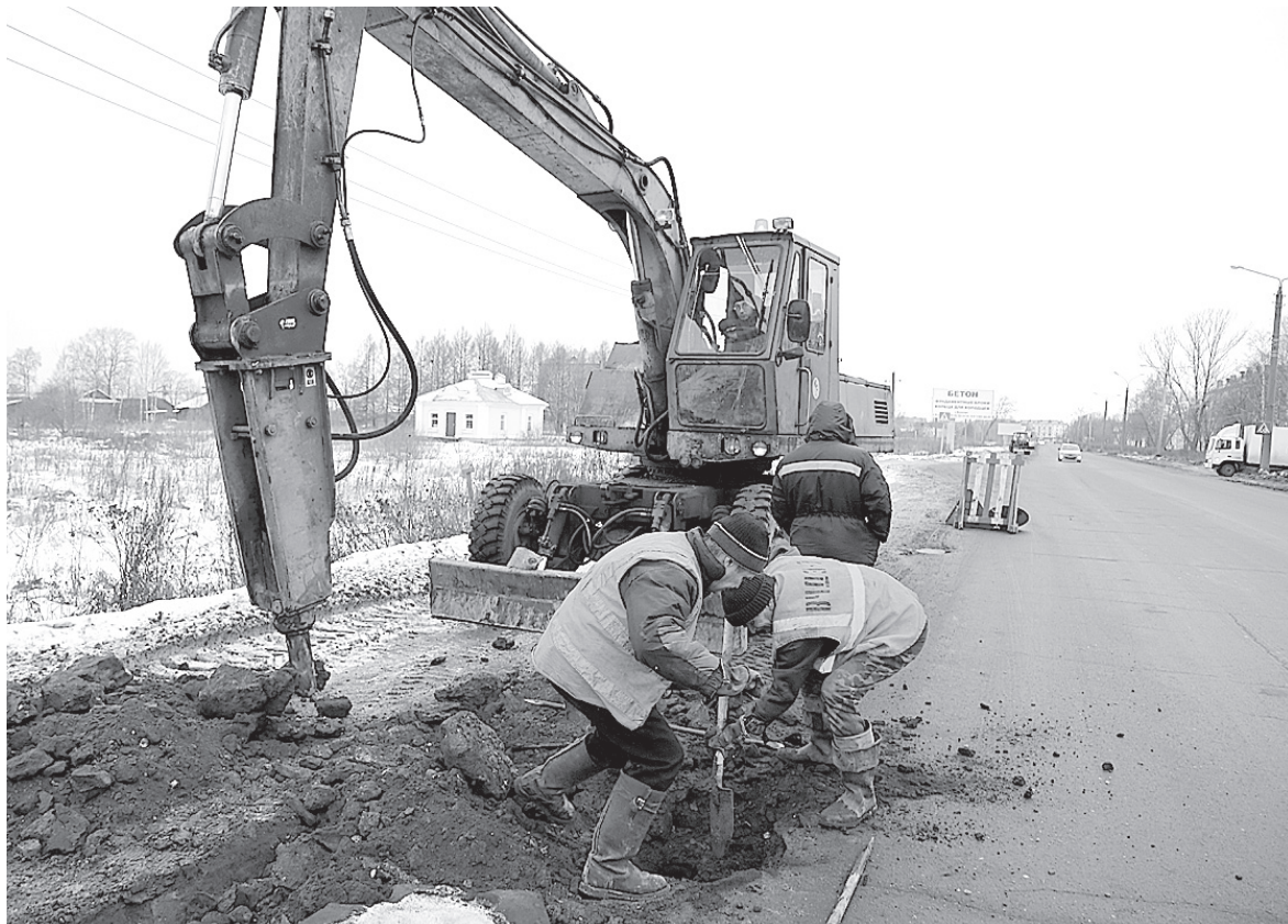
В течение 2014 года заменено 165 метров канализационных сетей.
