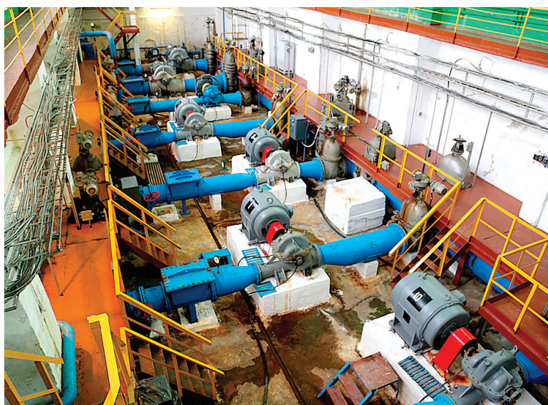
Цех очистных сооружений водозабора.
