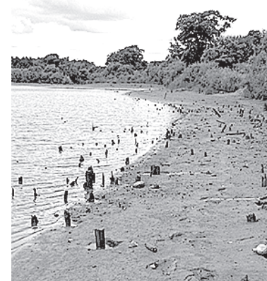
Так выглядели свайные конструкции.
