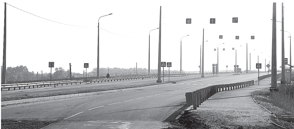
До 20 сентября работы по обустройству временного дорожного покрытия на съезде до улицы Залинейной должны быть выполнены. /Фото Валентины Певцовой
