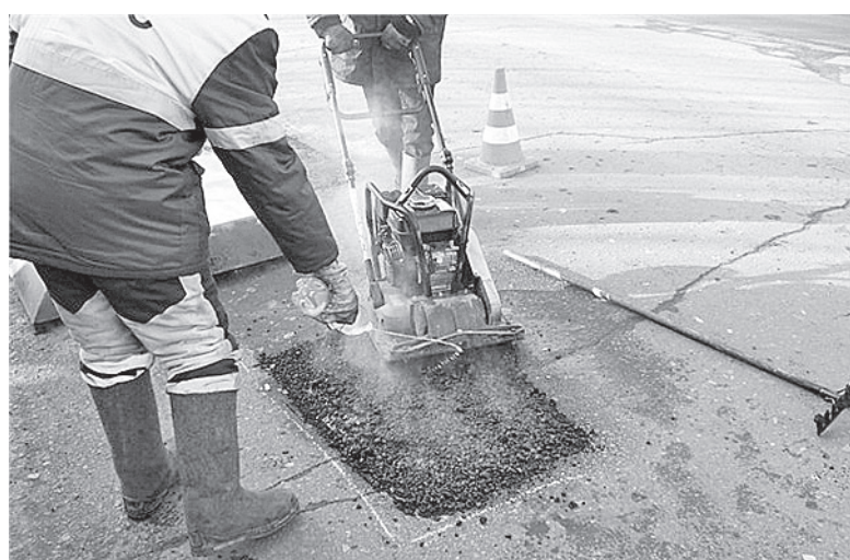
В Вологде уже готовы к ямочному ремонту.
