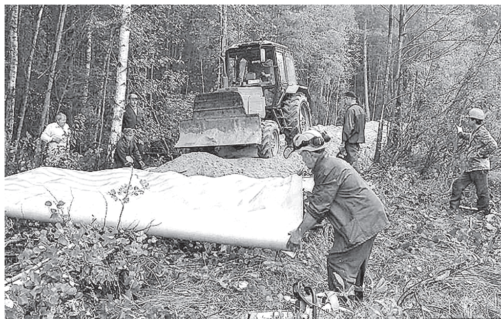
Нередко лесные дороги используются не только для вывоза древесины, но и как дороги для межпоселкового сообщения, трассы для подъезда при тушении лесных пожаров.
