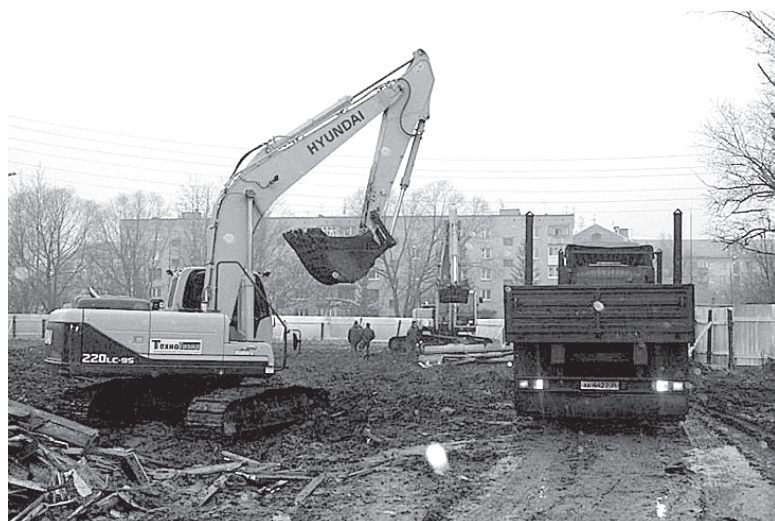
Фундаменты двух жилых домов появятся уже к Новому году.
