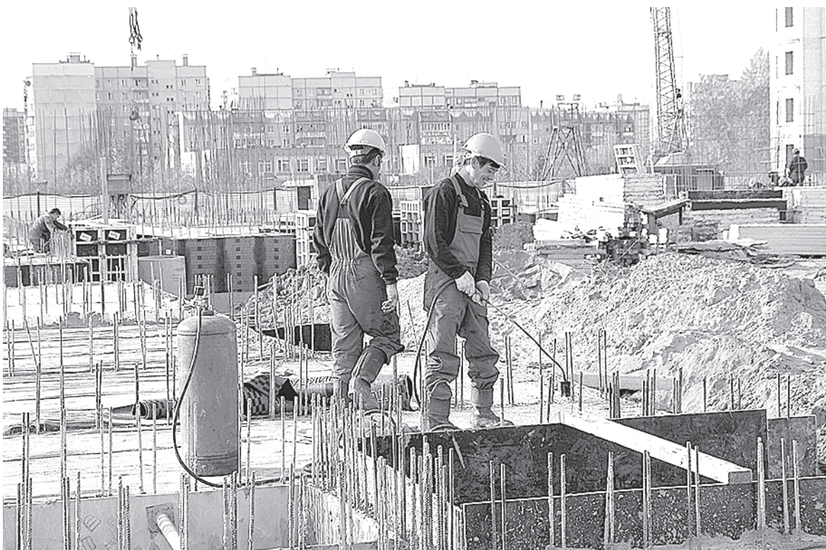
В основном вологодские фирмы привлекают трудовых мигрантов на работу в строительстве. /Фото Александра Коркка
