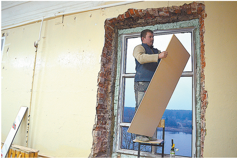
В стенах почти метровой толщины подрядчикам пришлось менять более 120 оконных блоков. /Фото Светланы Тропиной
