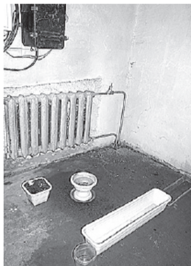
Протечки наблюдаются практически во всех помещениях здания.
