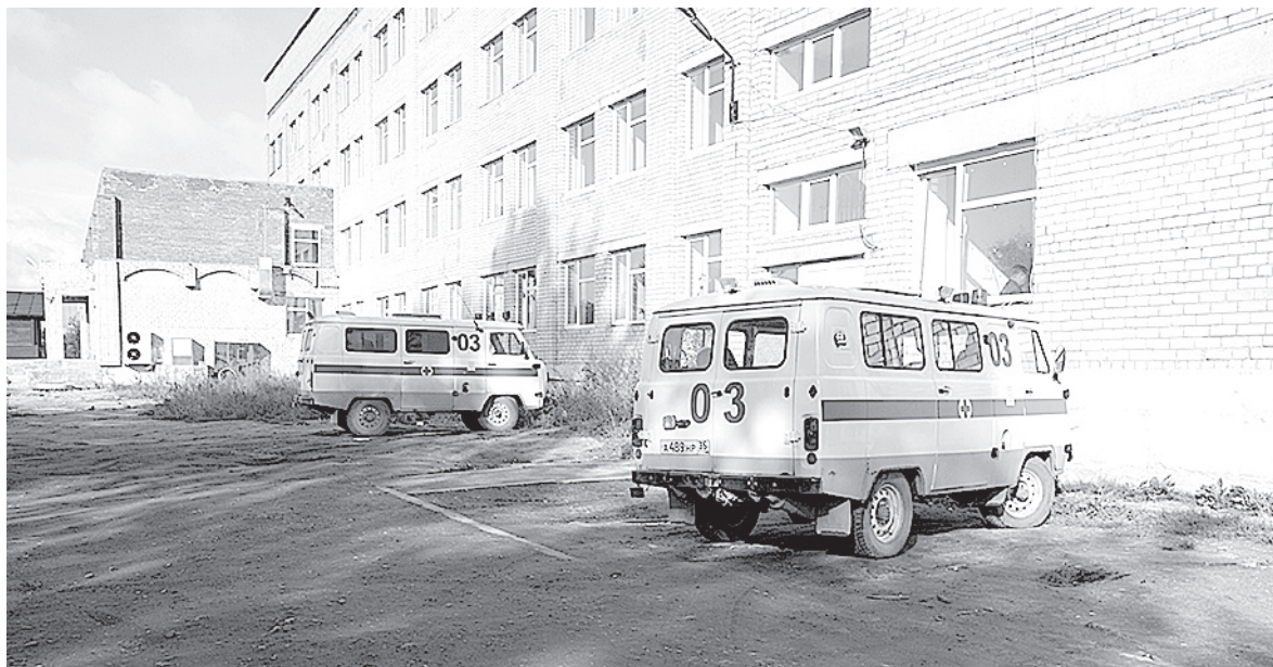
После капитального ремонта Кирилловская ЦРБ буквально преобразилась.
