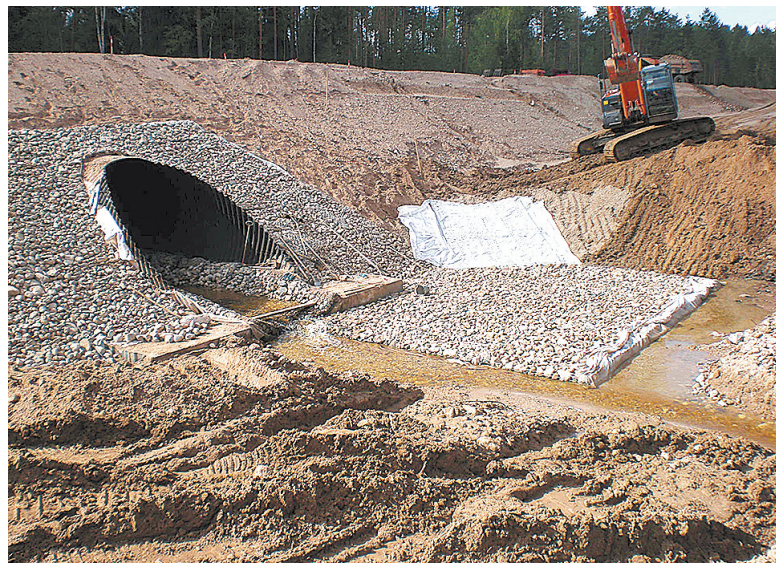
Ведутся укрепительные работы на водопропускной трубе на дороге Вологда-Архангельск.
