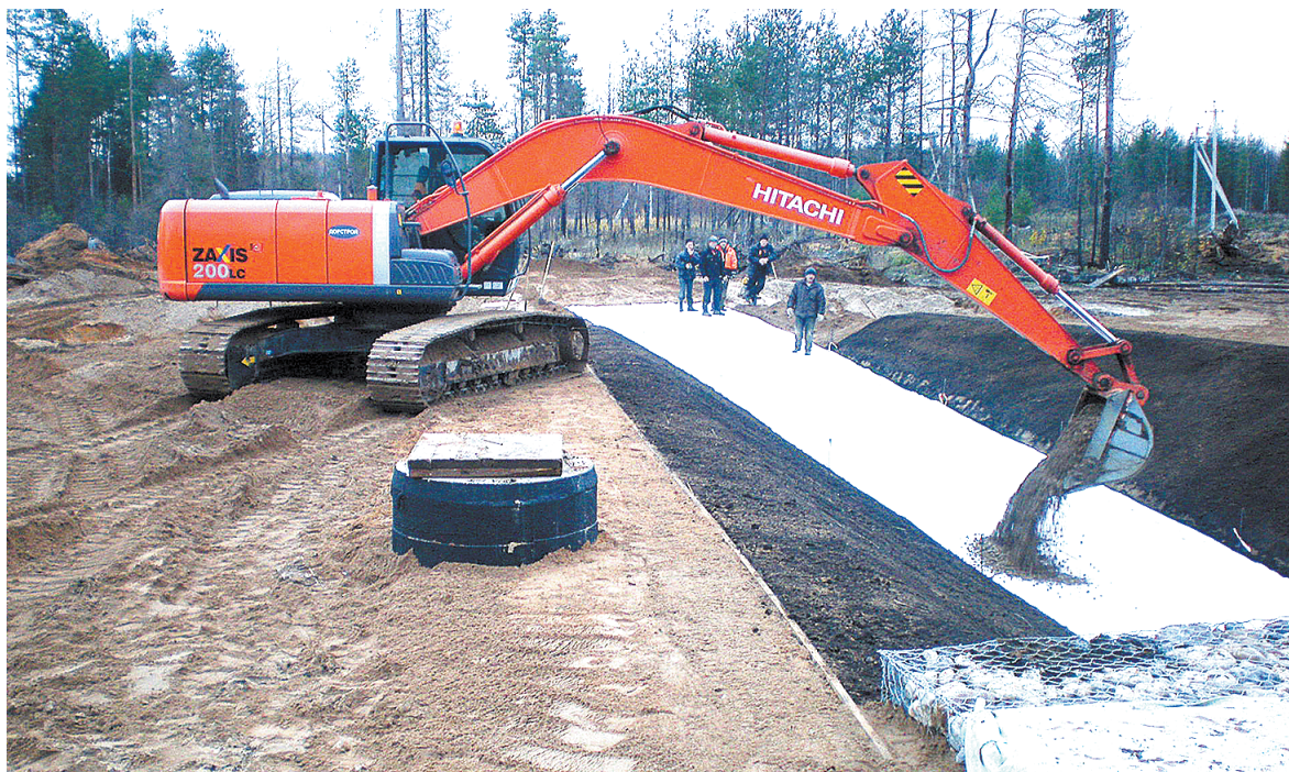
Ведутся работы на строительстве скотопроегона на обходе города Вельск.
