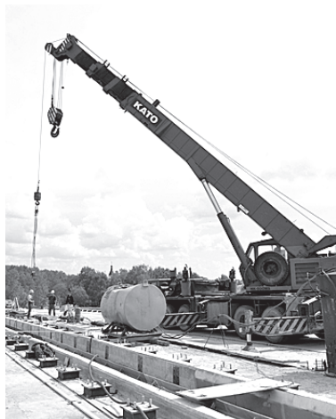
Работы на виадуке идут с опережением графика.
