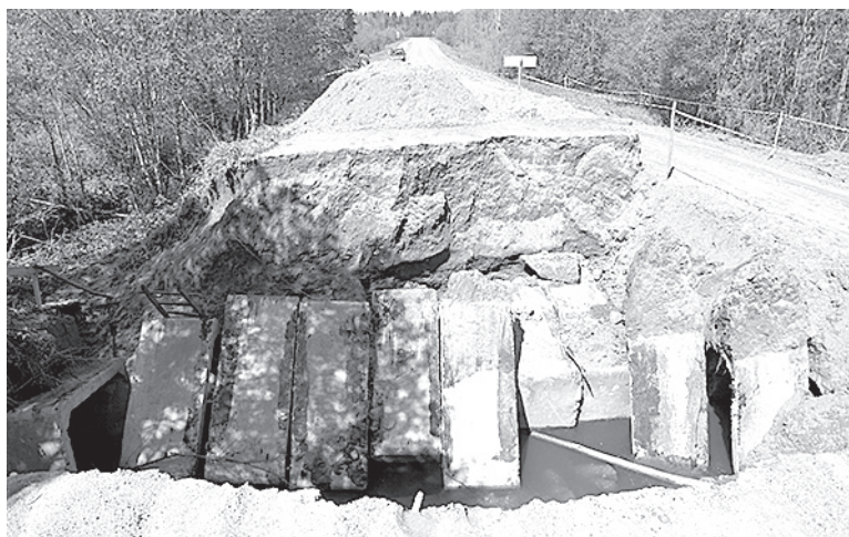
Работники Сосновской ПМК сделали объездную дорогу рядом с разрушенным мостом. /Фото Сергея Юрова
