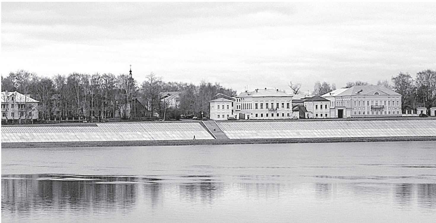
Укрепление левого берега реки Сухоны в Великом Устюге (1-й пусковой комплекс) - одно из наиболее значимых водохозяйственных мероприятий, реализованных в 2012 году.
