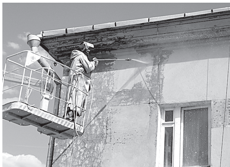
Реализованы две областные адресные программы по капитальному ремонту многоквартирных домов, в рамках которых отремонтировано 89 многоквартирных домов.
