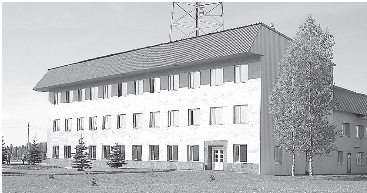
Все без исключения компрессорные станции Вологодчины отличаются чистотой и аккуратными газонами.
