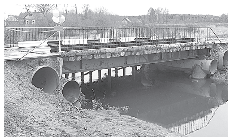
На месте аварийной переправы через реку Шингарь теперь новый мост.
