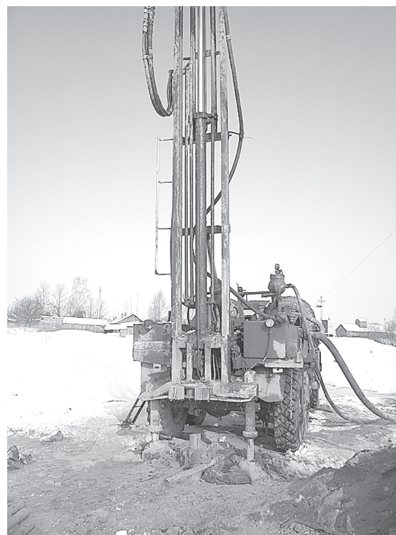
Бурение скважины в Усть-Кубинском районе.
