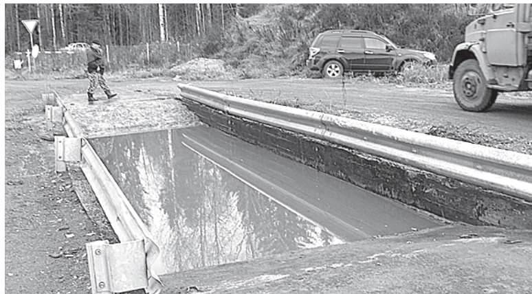
На выезде с полигона мусоровозы моют колеса в специальной дезинфекционной «ванне».
