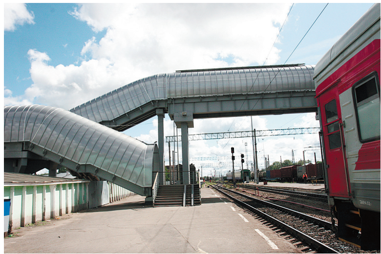
Более чем 200-метровый пешеходный мост через железнодорожные пути в Вологде считается самым длинным сооружением подобного типа на всем Северо-Западе.
