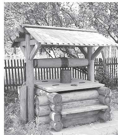
Санитарная зона колодцев составляет 20 метров.
