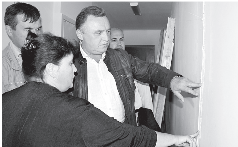
Евгений Шулепов проинспектировал новостройки и поручил подрядчикам до 1 октября устранить все замечания.
