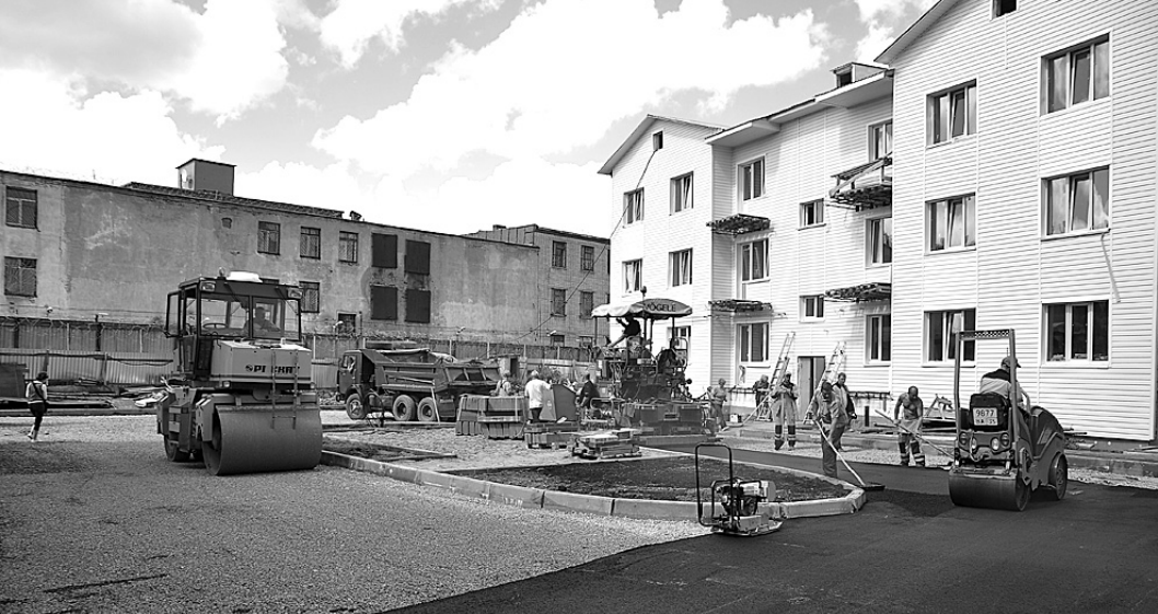
В Вологде продолжается строительство социального жилья.
