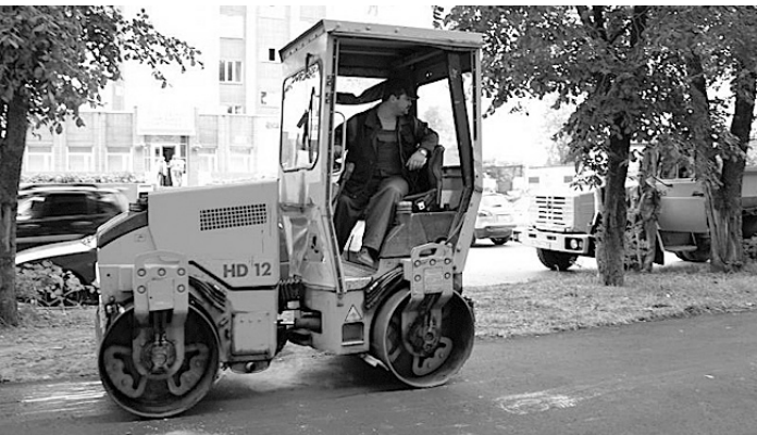
Тротуар отремонтировали за два дня. /Фото «Вологда-портала»
