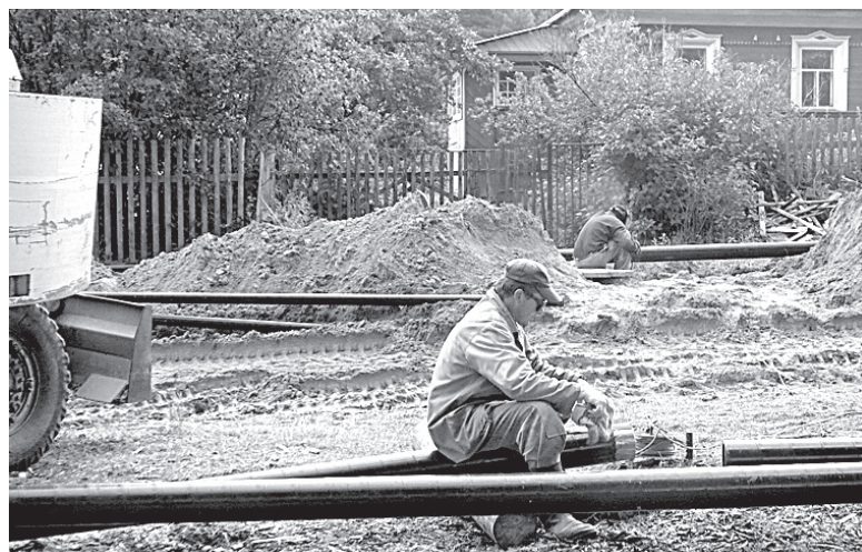
На улицах деревни Чуприно ведется прокладка труб. /Фото Галины Стакановой
