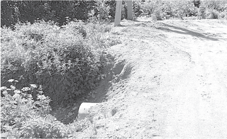
Водоотводная труба.
