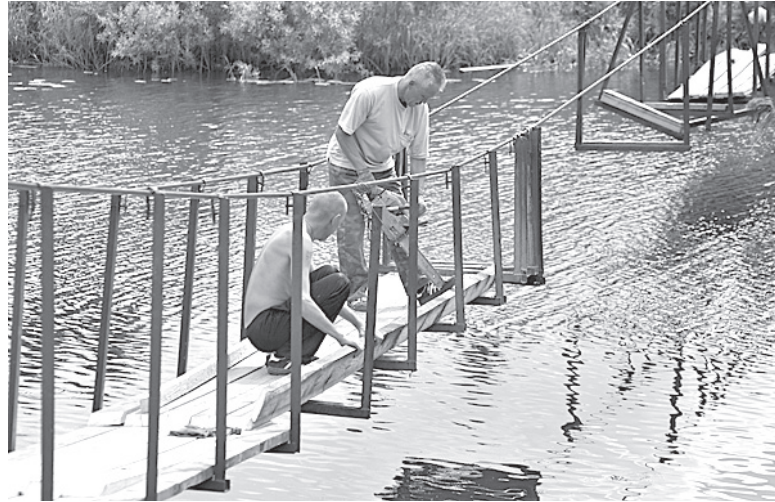
Работники СХПК «Майский» восстанавливают мост.
