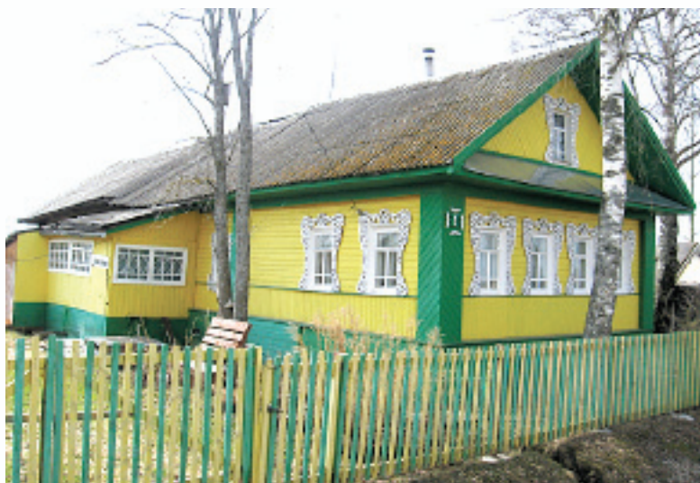
«Островной» дом № 1 задает тон местному благоустройству.
