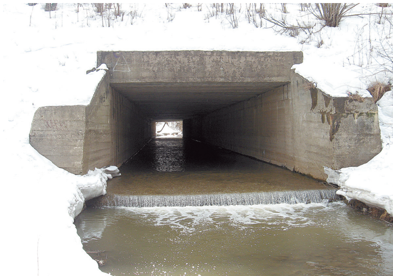
Водный тоннель в устье реки Золотухи также может считаться одним из вологодских подземелий.
