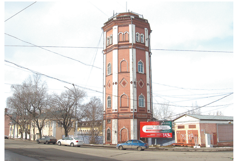
Именно от старой водонапорной башни когда-то начинался главный городской коллектор. /Фото автора
