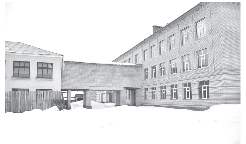
К концу года новый корпус тарногской школы будет полностью готов.
