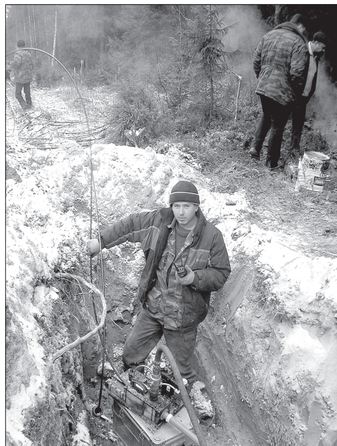
Прокладка волоконно-оптического кабеля.
