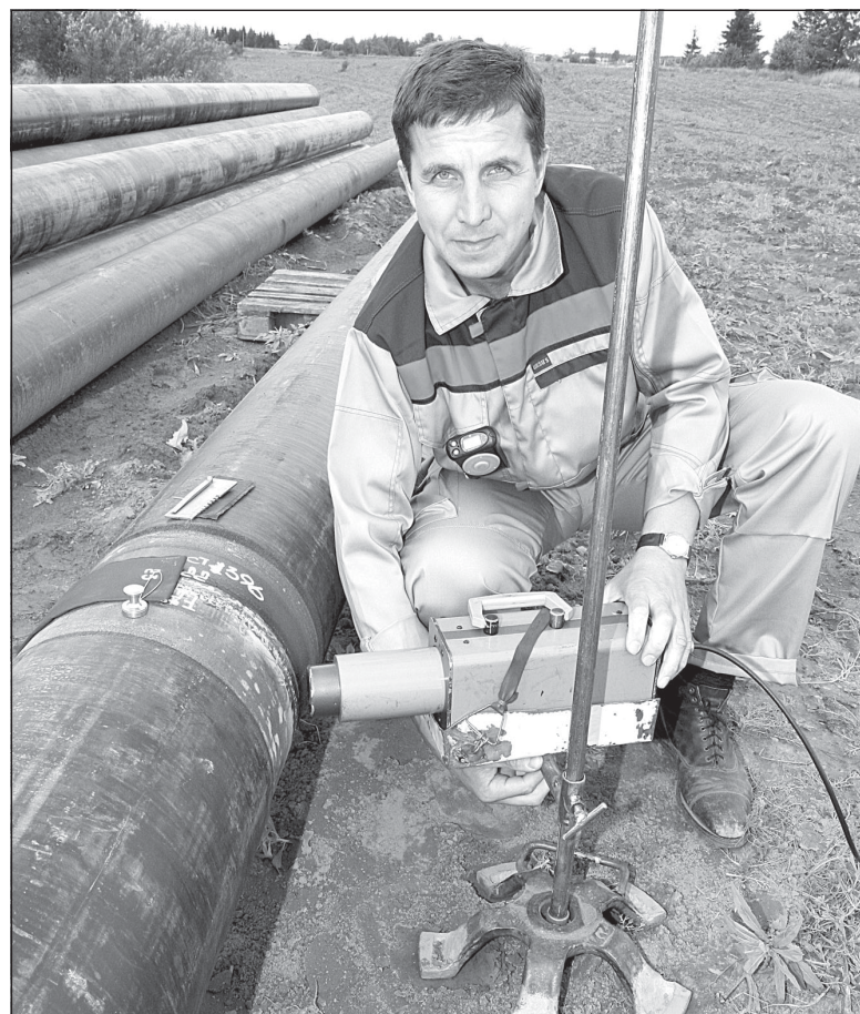
Идёт проверка сварных швов межпоселкового газопровода.
