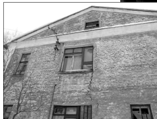
Один из корпусов больницы пришлось закрыть из-за образовавшейся на фасаде здания трещины.
