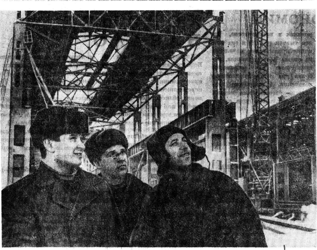
НА ЧЕРЕПОВЕЦКОМ металлургическом заводе полным ходом идет строительство цеха изложниц. Монтажным управлением «Севзапстальконструкция» предстоит в январе выполнить объем работ на 230 тысяч рублей. Коллектив участка старшего прораба Г. Ефимовича уже закончил монтаж более 3700 тонн металлических конструкций. Смонтировано 1600 кубических метров стеновых панелей из сборного железобетона, уложено свыше 2600 кубометров плит перекрытия. Особенно хорошо трудится здесь бригада кавалера ордена Трудового Красного Знамени В. Федюшкина. Она ежедневно значительно перевыполняет сменные задания при отличном качестве работ.
