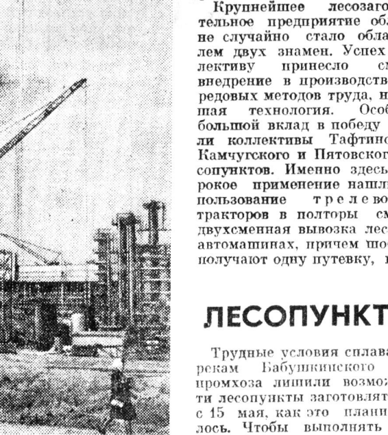
С КАЖДЫМ ДНЕМ все шире разветвляется панорама строительства Череповца: завод — первая большая химия в городе металлургов и строителей. Сотни тысяч тонн аммиака, слабой азотной кислоты, аммиачной селитры, которые даст азотный завод, пойдут на повышение урожайности сельскохозяйственных культур.
