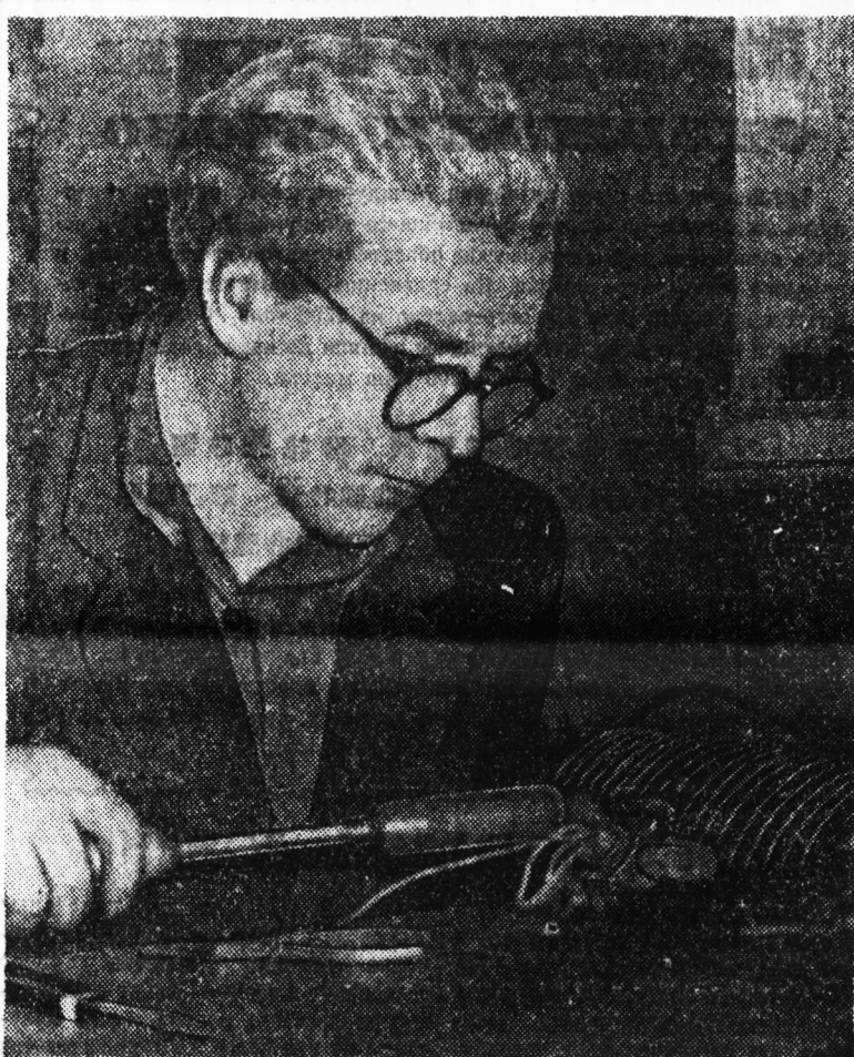
СПЕЦИАЛЬНОСТЬ, которой владеет Борис Николаевич Рухов, встречается довольно редко — слесарь по ремонту локомотивных скоростных мер. Умный это прибор — скоростмер. Он одновременно показывает давление воздуха в тормозной магистрали, время нахождения в пути, скорость движения поезда и пройденный путь, что значительно облегчает труд железнодорожников.
