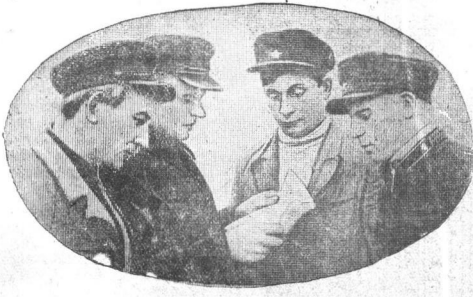
Лучшей бригадой на третьем прорабском пункте второго участка строительства вторых путей является путевская бригада тов. Максимова.
