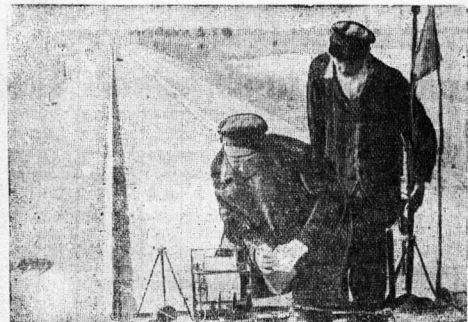
На снимке: мастер А. П. Ремов и бригадир Д. М. Мошняков на станции Шелогово проверяют железнодорожный путь по кривоносовой шпале.
