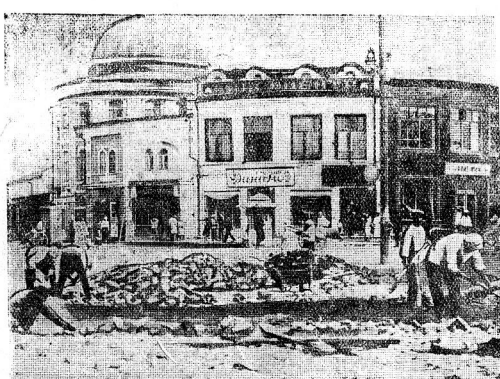
К 15 сентября будет исправлено 2635 кв. метров мостовой на площади Свободы. На снимке: момент замощения площади.
