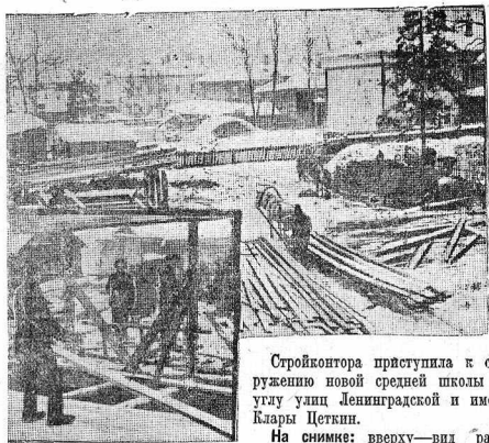
Рабочие стройконторы за сооружением здания.
