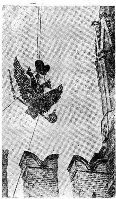
18 октября верховными были сняты орамы с Никольской и Спасской башен кремлевской стены. Оба орама были сняты в целом виде при помощи специально построенных башенных кранов.
