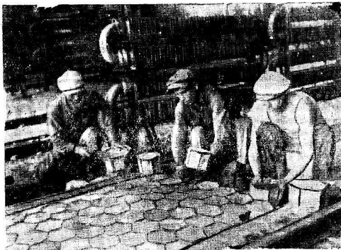
Парниковое депо ст. Вологда готовится к зиме. Вязные депо капитально переоборудуются и степелятся. На фото: ремонтная бригада т. Шагина за укладкой торцового пола в паровозном депо.
