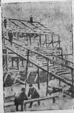
Деловой новый пассажирский вокзал строит в Вологде завод для Тотемской орстанки.
