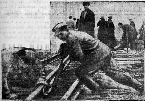
Ремонт пути к зиме. Фото Бровозовского
