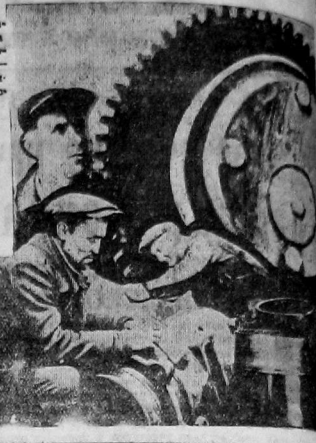
Монтажник Колосов работает в цеху парохосового станка. Внизу—осмотряют цеховым делом затона
